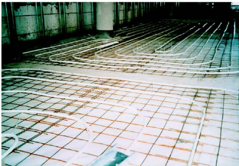
Fig. 12: Sistema de malla soporte de tubos
