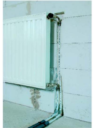
Fig. 4: Ejemplo de instalación: conexión de un radiador estándar con conexión en ángulo RAUBASIC press
